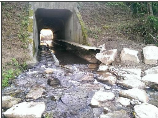
*Exemple de passage inférieur sous voie avec le loutrodoc des Coux (route de Luçon) à La Roche-sur-Yon*
