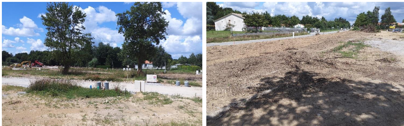
Figure 4. Quartier d'habitation en cours de construction sur le secteur du « Plessis » et de La Garlière » à l'ouest du centre-bourg de Venansault, en extension de ce dernier © Biotope, juillet 2021
